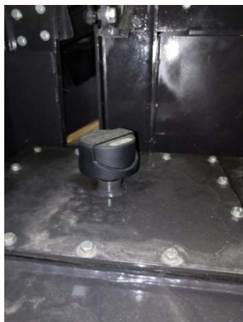
Imagem 5-5 Obstrutor de ventilação do tanque de óleo hidráulico
